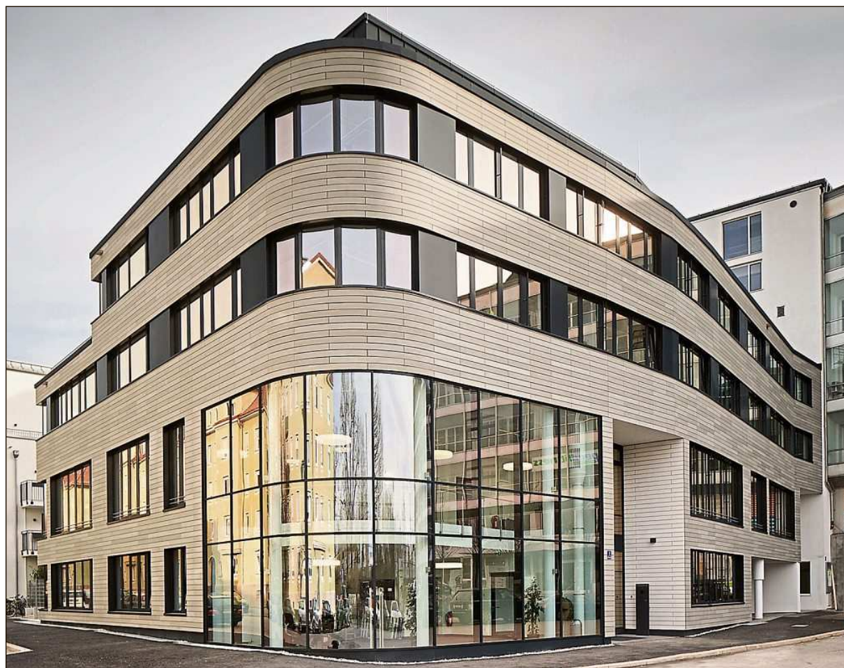
Das neue Haus der Bayerischen Zahnärzte. Die Galerie und der Eingangsbereich.
